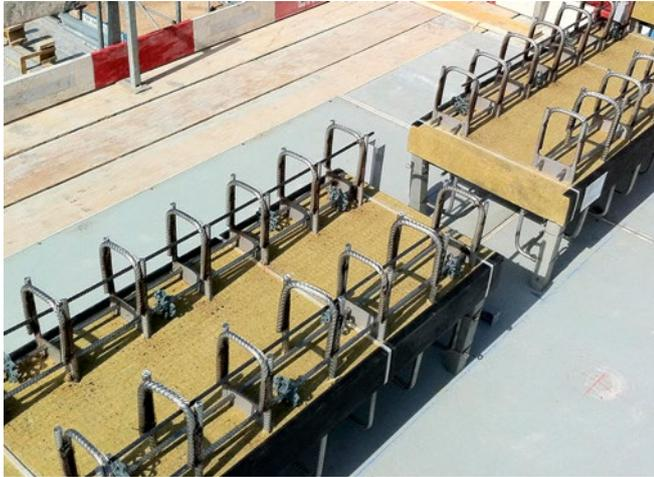
Vertikale Vordachanschlüsse auf Dachrand
