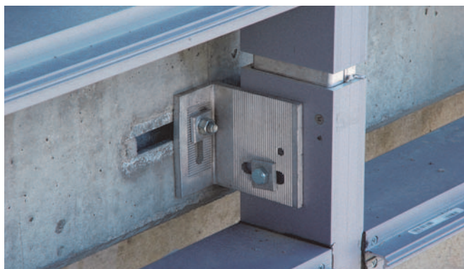
Befestigung einer Pfosten-Riegel-Fassade mittels HCW-ED Bracket an HTA-CE Ankerschienen
