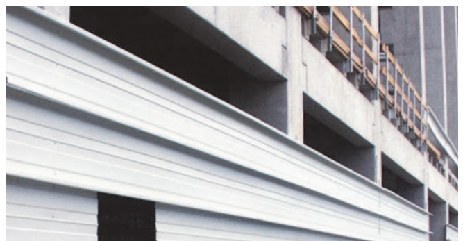
Montierte Wandkassetten am Flughafen Köln/Bonn
