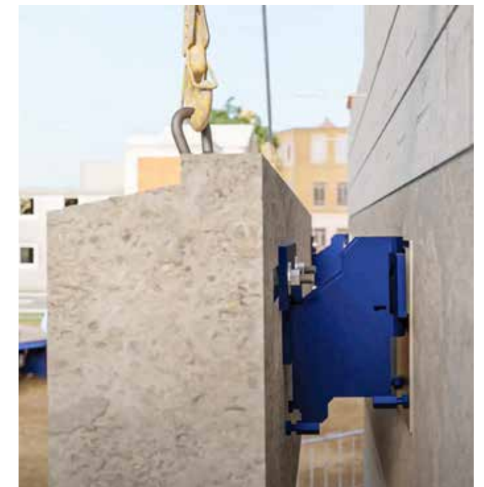
Met de Halfen HPF prefab verankeringsoplossing voorziet Leviat in een snelle en praktische montage van bijvoorbeeld geprefabriceerde betonbanden.
