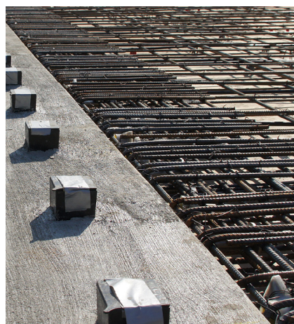
Preliminary pour using the Halfen HSD-LD
