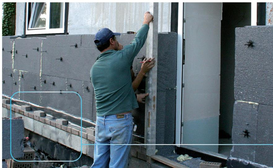
Dans le cadre d'une construction passive, les épaisseurs d'isolation de 30 cm ne font pas exception. Les grands vides ne posent pas de problème supplémentaire pour l'application des supports de façade Korbo. L'utilisation de matériau en inox, dont le coefficient de conductibilité thermique est considérablement inférieur à celui de l'acier galvanisé à chaud, est indispensable pour une construction passive.
