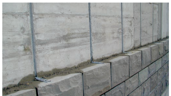
Ancrage de maçonnerie avec Halfen ML
