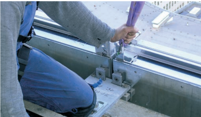
Fixation d'une façade modulaire à l'aide de supports HCW-ED sur des rails inserts HTA-CE
