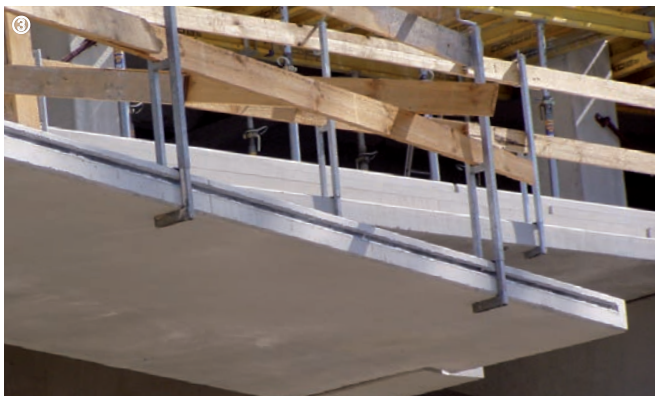
①-④ : Installation de barrières de sécurité, salle omnisports de Berlin
