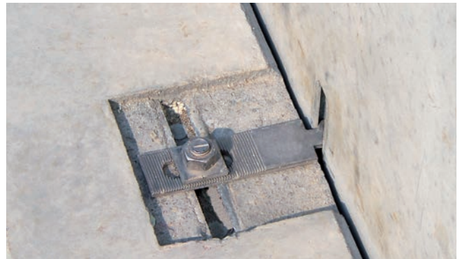
Patte d'ancrage Halfen HKZ avec rondelle crantée
