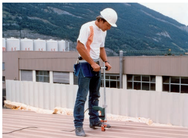
Fixation de tôles trapézoïdales à l'aide de vis autoperçantes
