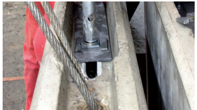
Système HVL avec éléments de construction pré-montés
