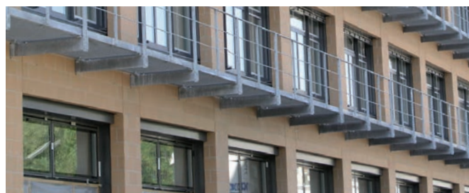
Fixations pour balcons d'accès d'urgence (installation verticale de rails Halfen)
