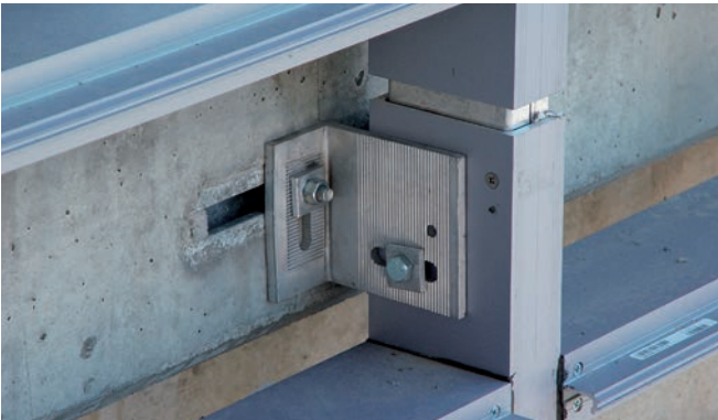
Fixation d'une façade à poteaux et poutres à l'aide de supports HCW-ED sur des rails inserts HTA - CE
