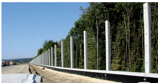
Fixations de barrières anti-bruit sur des poteaux en béton
