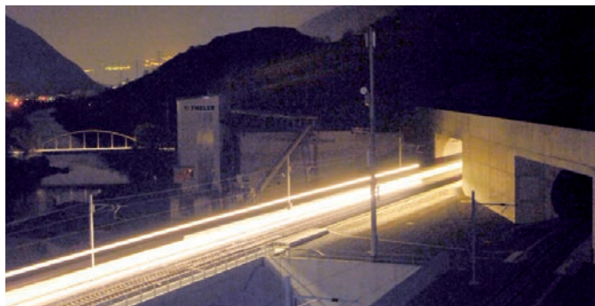
Tunnel de base du Lötschberg, Suisse
