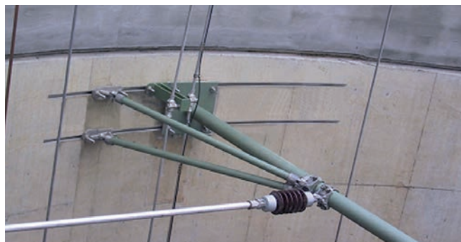
Fixation de câbles aériens dans les tunnels ferroviaires
