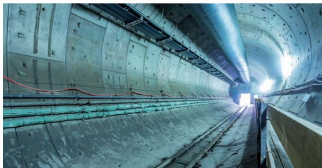
Fixations techniques dans les tunnels TBM avec rails à ancrés incurvés
