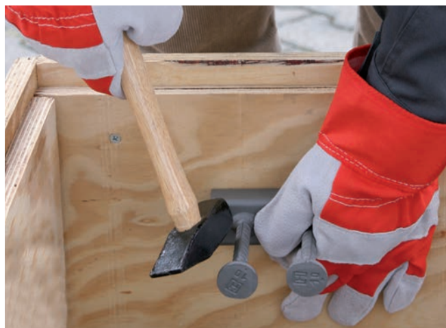
Clouez le rail insert Halfen sur le coffrage
