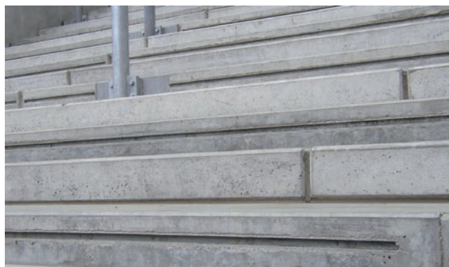
Fixation de rails de sécurité, Rheinenergiestadion de Cologne
