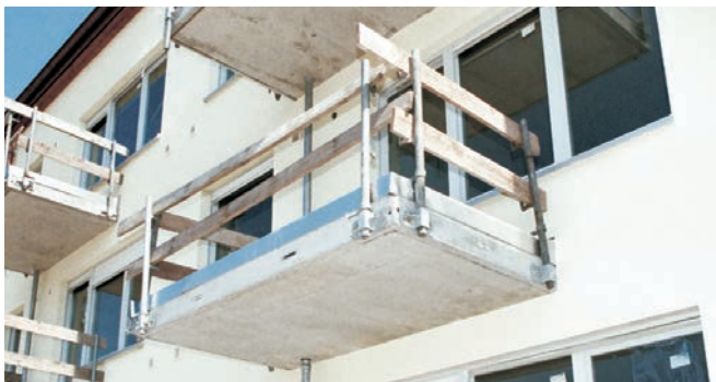
Utilisés pour la fixation de rails de sécurité durant la phase de construction
