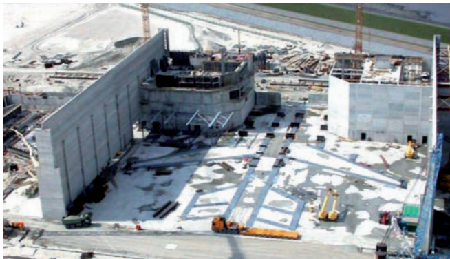
Halles de peinture Airbus avec pattes d'ancrage Halfen HVL
