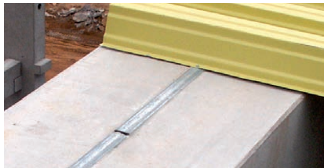
Fixation de tôles trapézoïdales pour toitures
