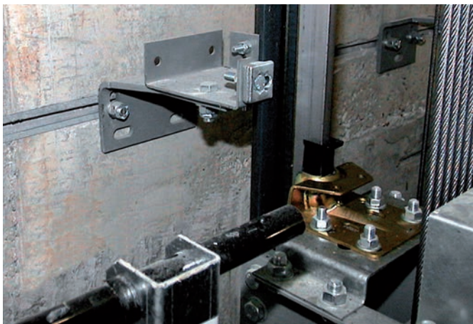
Fixations de rails de guidage
