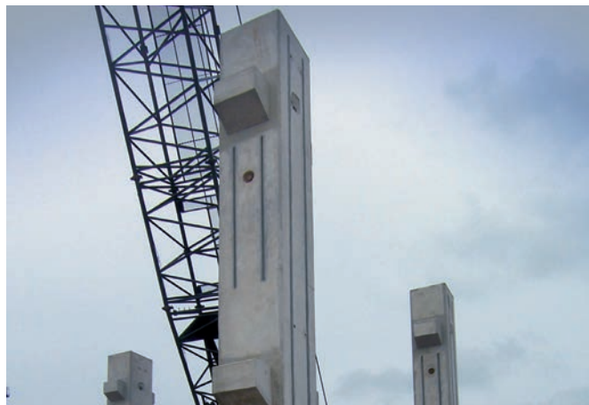
Rails verticaux dans les poteaux permettant la fixation d'autres composants
