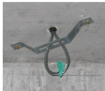
Boucle d'ancrage montée dans la dalle de la cage d'ascenseur
