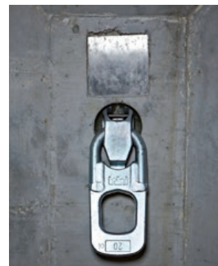
Accouplement enclenché avant la pose de la chaîne de sécurité
