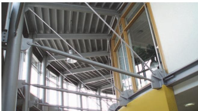
Contreventement entre un poteau extérieur en acier et une poutre intérieure en acier
