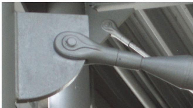
Système de compression raccordé à un gousset soudé
