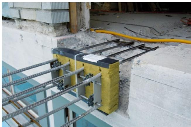
Connexion à un objet existant (avec décalage de niveau)
