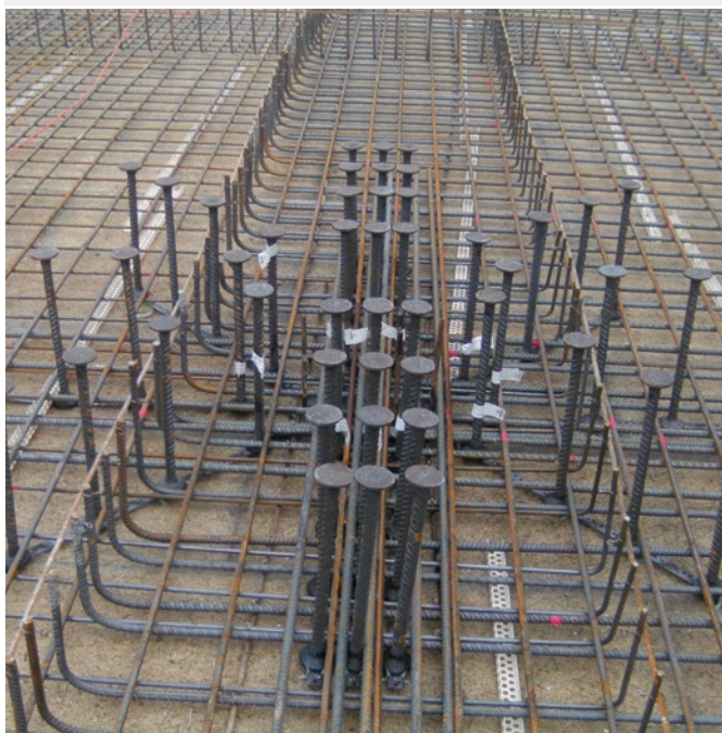
Indication du diamètre sur la tête du goujon et identification du goujon le plus proche de la colonne.
