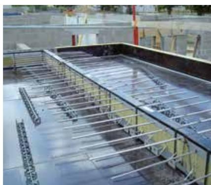
Le nouveau rupteur ISOTEC RT+ avec son isolant de 80mm respecte les réglementations en vigueur les plus exigeantes.
