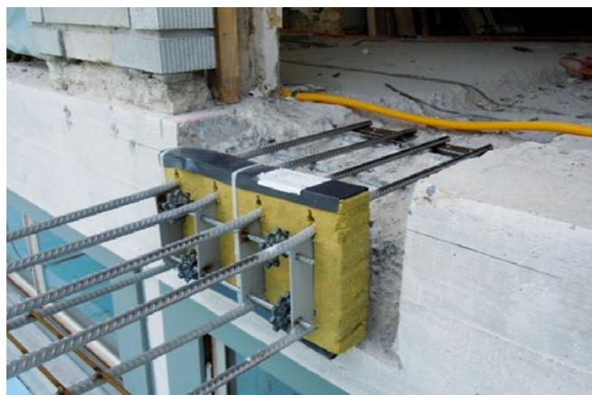
Collegamento all'edificio esistente (con saliente di livello).
