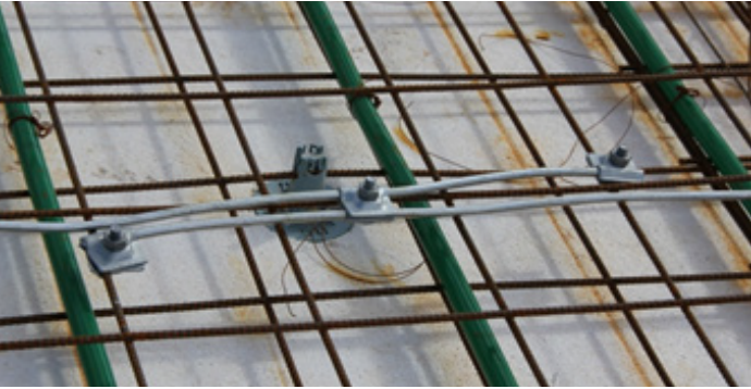
Skarv av linan görs med multiklämma. Ovan visas ett exempel.
