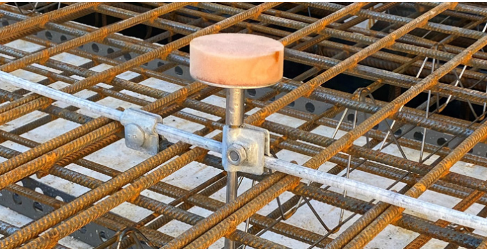
Montage av kontaktplatta uppåt. Monteras i höjd med tänkt gjutning. I anslutning till Elcentral eller där jordpunkt önskas.
