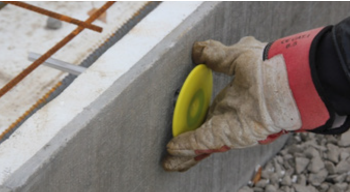
Genom kantbalken monteras kontaktplatta. Alternativt monteras kontaktplattan uppåt.
