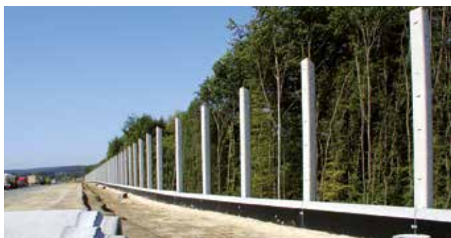
Bevestiging van geluidschermen aan verticale betonkolommen
