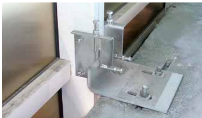
Bevestiging van een zuivere vliesgevel met HCW-B2 consoles aan HTA-CE ankerrail
