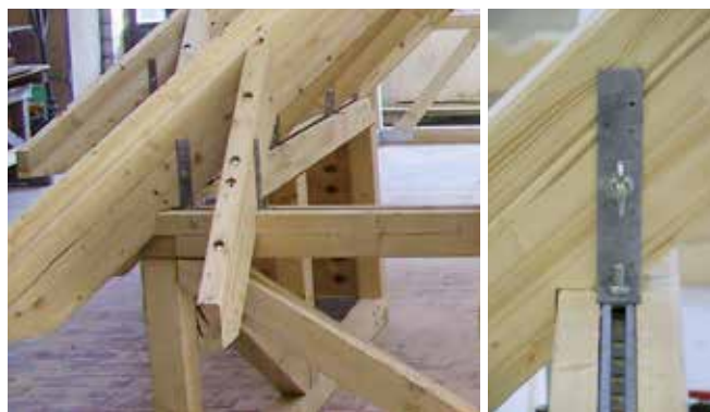
Houten dakconstructie met HALFEN HNA spijkerankers
