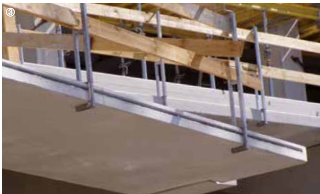
①–④: Bevestiging van balustrades, multifunctionele hal, Berlijn
