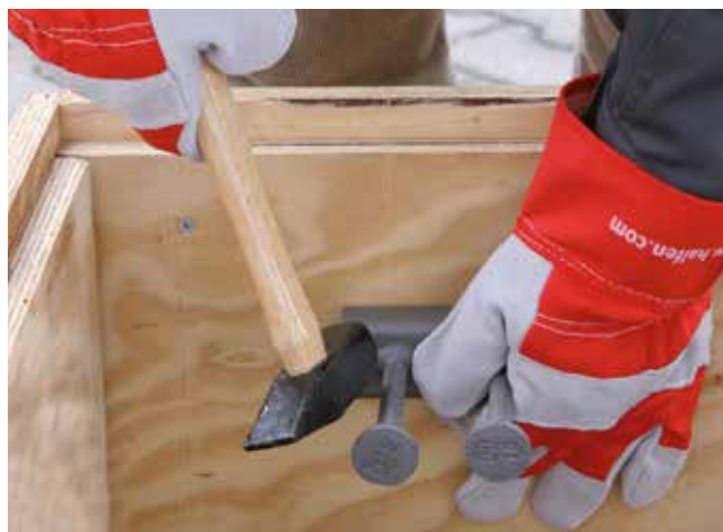
Halfenrail aan de bekisting spijkere
