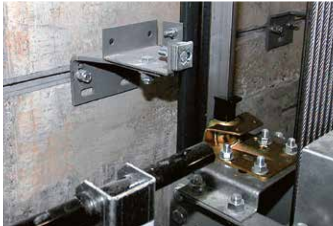
Bevestiging van geleiderail
