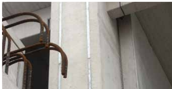
Verticale HTU rail voor de bevestiging van gevelbekleding
