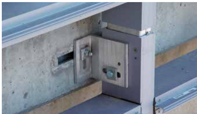
Bevestiging van een onzuivere vliesgevel met HCW-ED consoles aan HTA-CE ankerrail
