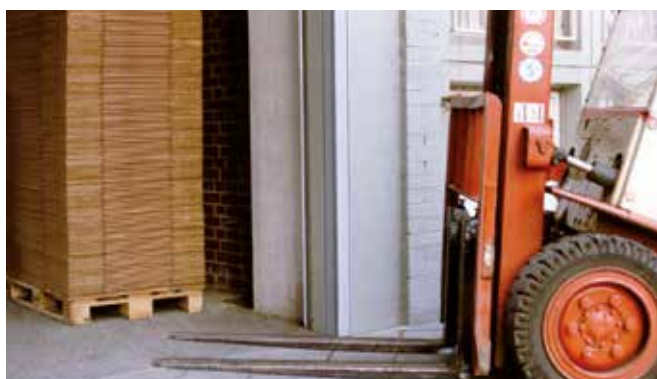
HCW hoekbeschermingsprofiel op de hoek van een wand in een fabriek
