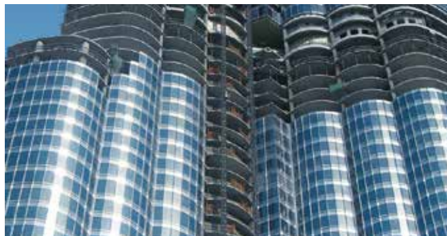
Bevestiging van een vliesgevel
