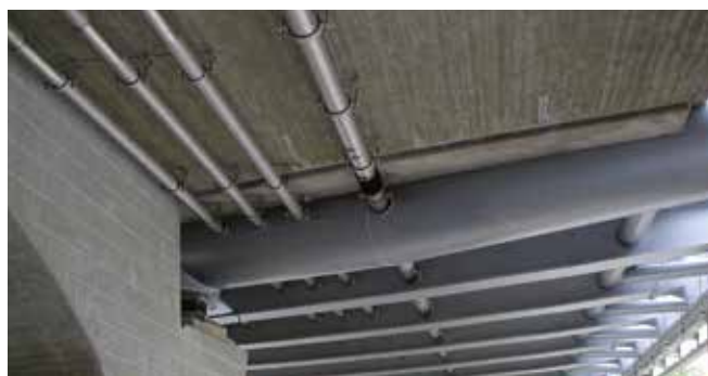
Bevestiging van hemelwater afvoer leidingen
