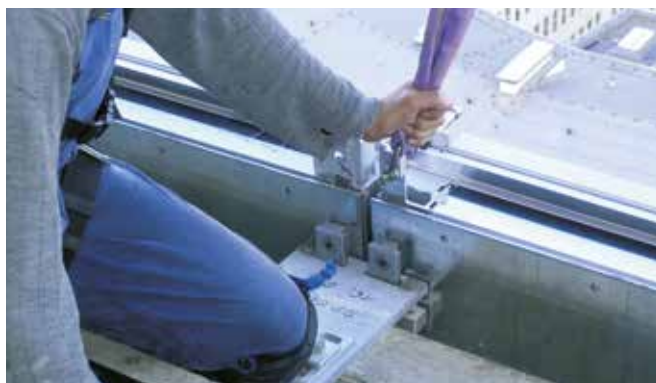
Bevestiging van een zuivere vliesgevel met consoles aan HTA-CE ankerrail
