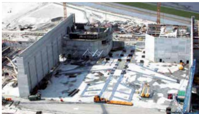
Airbus spuiterij met HALFEN HVL prefab aansluiting
