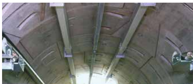
Gebogen Halfenrail in Tübbing-elementen
