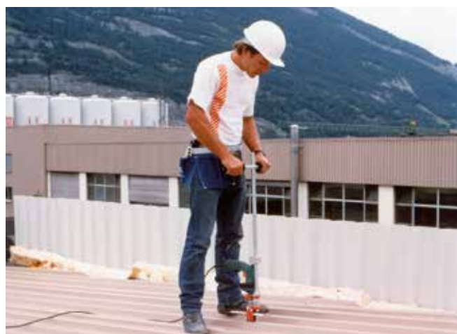
Vastbouten van geprofileerde dakplaten d.m.v. zelfborende schroeven
