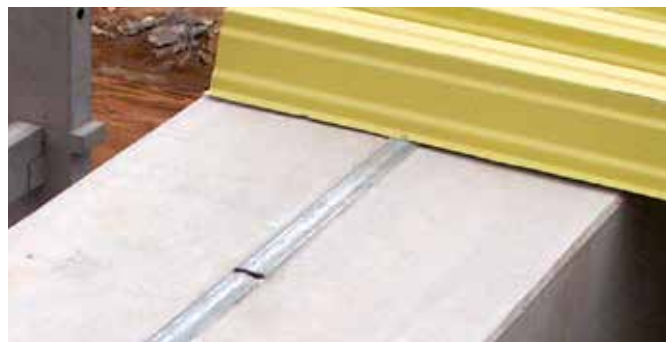
Bevestiging van geprofileerde dakplaten
