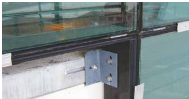
Bevestiging van een vliesgevel
