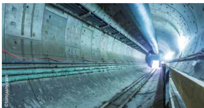
Spoortunnel met gebogen ankerrail
