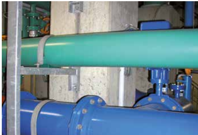
Ondersteuning van pijpleidingen aan verticale HZA rail
