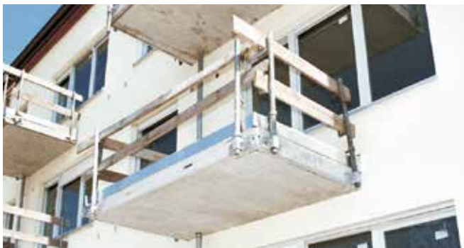
HGB tijdens de bouwperiode in gebruik als valbescherming
