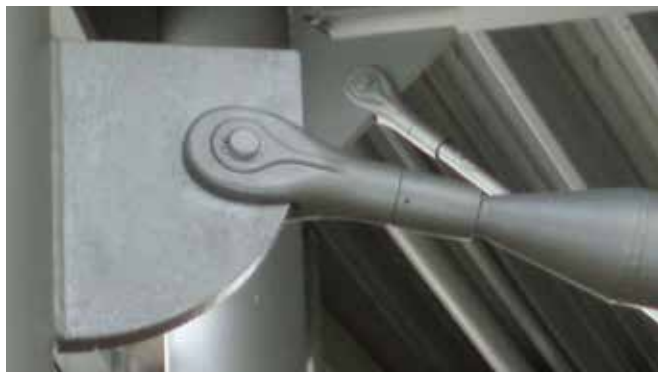
Drukstangstelsel bevestigd aan een aansluitplaat
